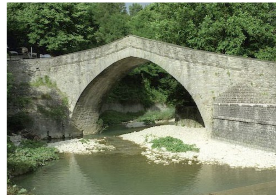
1 - Ponte Medievale "a schiena d'asino" ( XIII° secolo)
